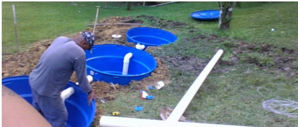
Figura 4: Projeto de fossa biodigestora na propriedade 02, executado em Abril de 2017. Fonte: Os autores.
