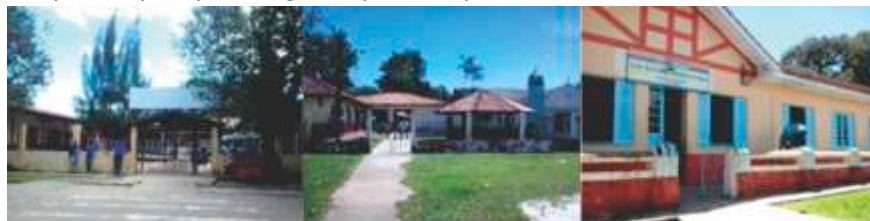
Fotos 5, 6 e 7: Escolas em Mosqueiro
