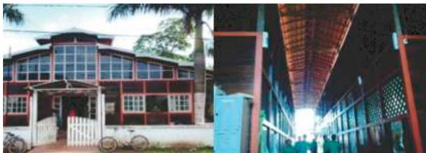
Foto 3: Fachada da escola
