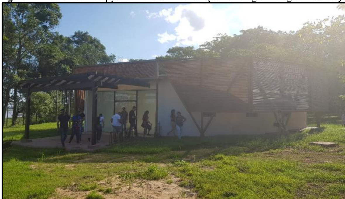
Figura 10 – Centro de Recepção ao Turista em construção no Refúgio Biológico Mbaracayu.
