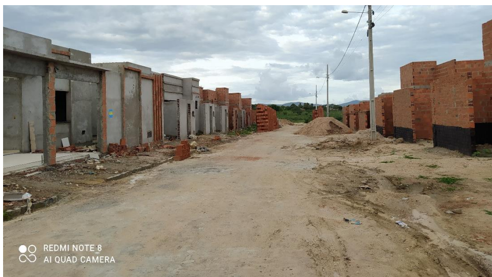
Figura 6 - Casas em processo de construção no loteamento Santa Mônica II.
