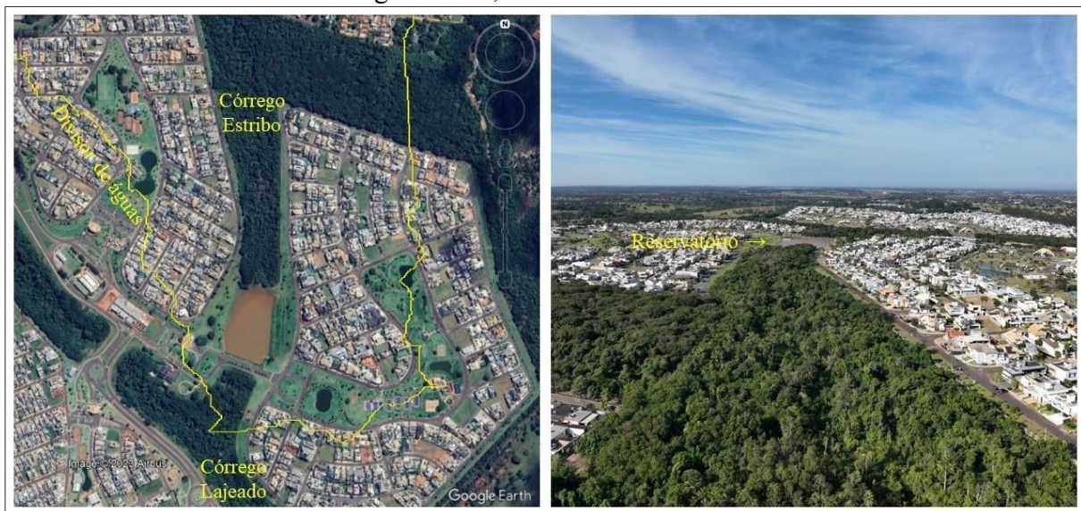
Figura 8 - Reservatório formado a partir da construção de uma barragem de terra no baixo curso do córrego Estribo, em área do condomínio Damha.
