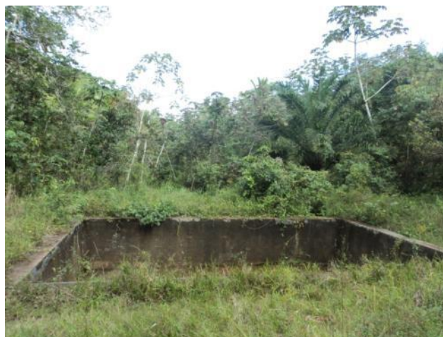
Figura 08 – Antiga Piscina Privatizada em Local de Grande Antropização e Vegetação de Capoeira.
