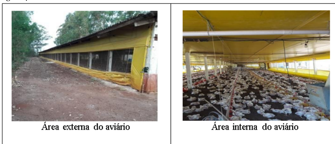
Figura 4- Áreas externa e interna de aviário convencional do Produtor 1
