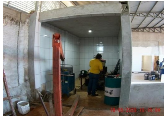
Figura 8 – Edificação da área de lavagem de peças.
