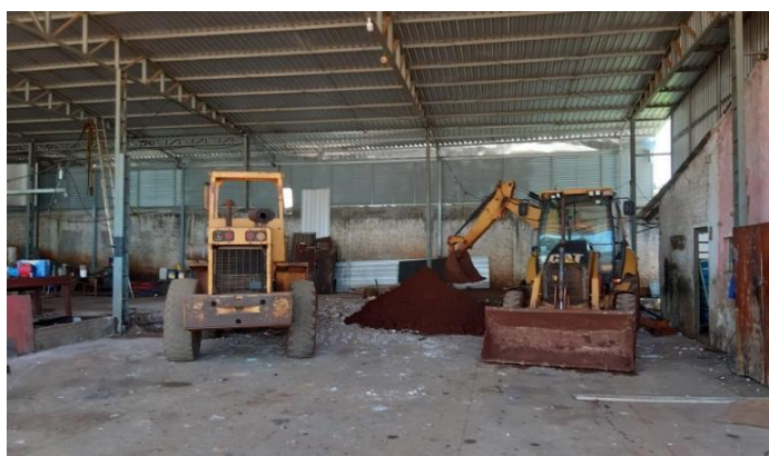
Figura 3 – Inicialização das obras de melhorias na oficina.
