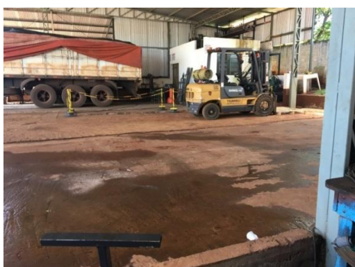
Figura 1 – Oficina antes da reforma.
