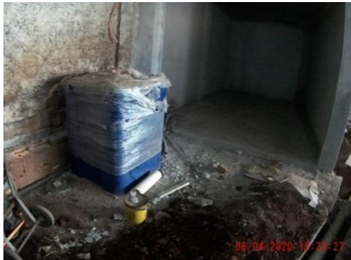
Figura 7 – Edificação da área de lavagem de peças.
