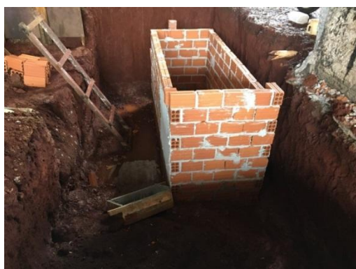
Figura 5 – Estrutura em alvenaria para acomodação das caixas separadoras.
