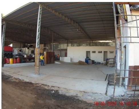
Figura 9 – Reestruturação do piso da oficina.
