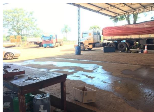
Figura 2 – Oficina antes da reforma.
