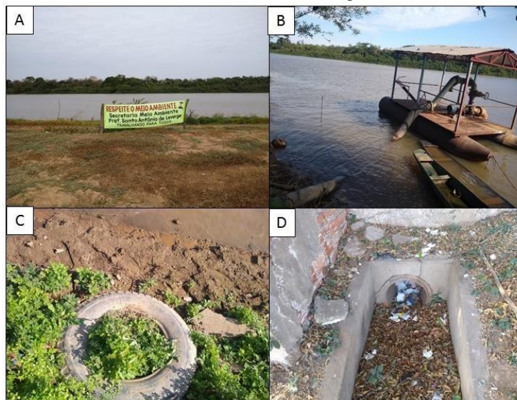
Figura 5 - Registros fotográficos de aspectos e impactos ambientais observados na Praia Bar, localizada em Santo Antônio de Leverger – Mato Grosso
