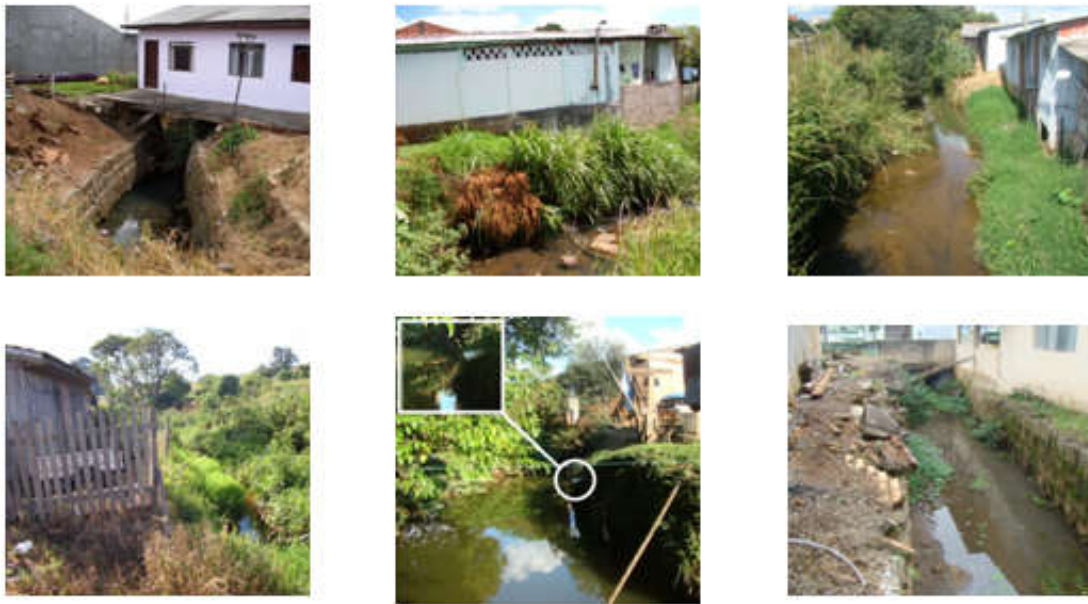
Figura 5 – Residências localizadas em áreas potenciais a inundação
