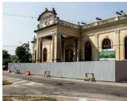
Figura 2: Estação de Paranaguá: fachada principal em 2017. Fonte: Castro, W. R. Data: Outubro de 2017.
