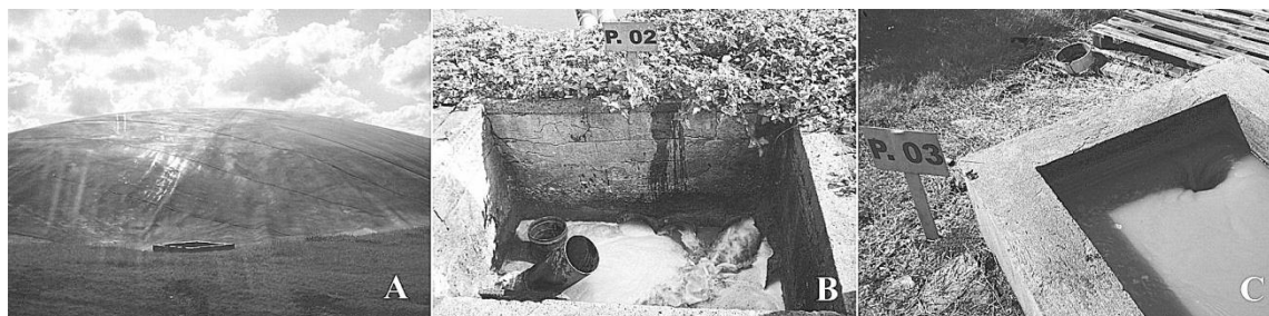
FIGURA 1 - Biodigestor (A), entrada do biodigestor (B), e saída do biodigestor (C).
