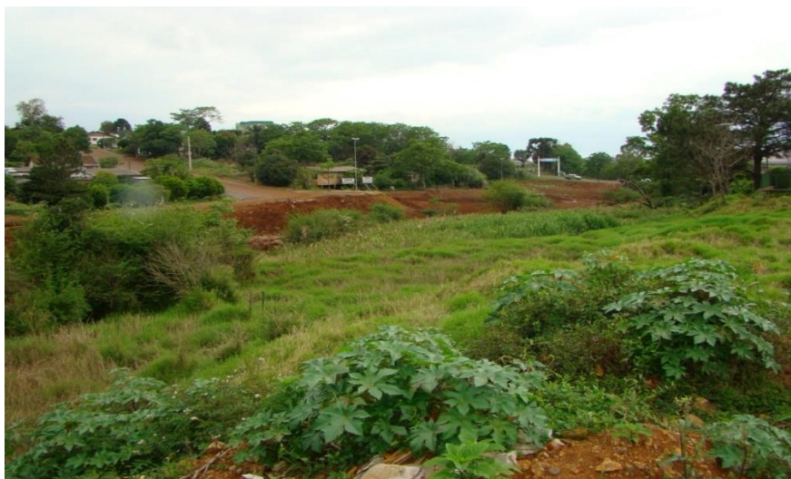
Foto 4 – Imagem do início das obras do Parque Turístico Ambiental.
